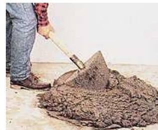
químicos que en ella se producen. El mortero se adhiere a las superficies más o menos irregulares de los ladrillos o bloques y da al conjunto cierta compacidad y resistencia a la compresión. Los morteros se denominan según el conglomerante utilizado: mortero de cal, o de yeso. Aquellos en los que intervienen dos conglomerantes reciben el nombre de morteros bastardos.
