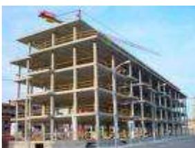
Para superar este inconveniente se introducen en el hormigón barras de acero, siendo entonces este material quien lleva los esfuerzos de tracción. Es usual, además, disponer barras de acero en zonas
